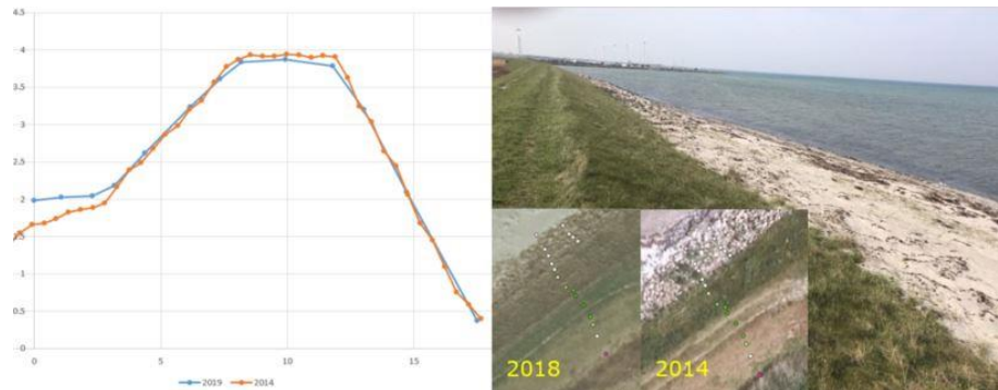
Figur 3.3: Tværsnit B viser terrænoverfladen i 2019 (blå linje) og i 2014 (orange linje). Digeprofilen er stort set identisk, dog ser det ud til at der er mere vegetation på digekronen i 2014 og at der er sandaflejring på havværts side (venstre del af grafen).
