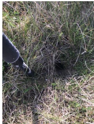
På den første (nordlige) del af diget, er der ikke fundet skader, men der er fundet faunaspor i form af gravehuller i diget, se Figur 3.4.
